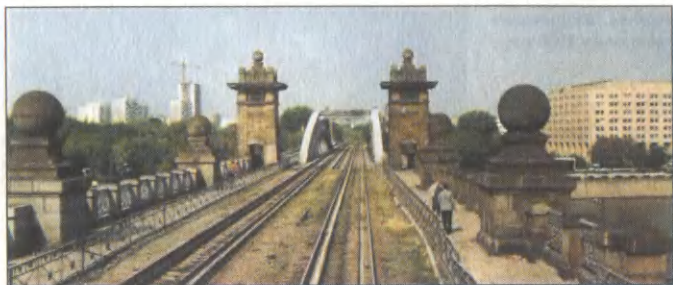
Железнодорожный мост на Дорогомиловской.
